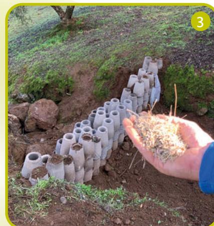
Albarrada para corrección de cárcava con piezas tipo SoilProtect (1); albarrada para corrección de cárcava con protección aguas abajo con paneles biotecnológicos (2); y albarrada para corrección de cárcava con sembrado para protección de taludes (3).
